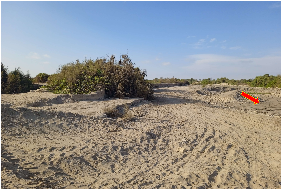
FIGURA N°02: MATERIAL COLMATADO EN EL CAUCE DE LA QUEBRADA HOSPICIO, CON UNA PROFUNDIDAD PROMEDIO DE 1.50 M. ESTO PROVOCA QUE DESBORDAMIENTO DE LA QUEBRADA HOSPICIO SEA MAS INMINENTE.
